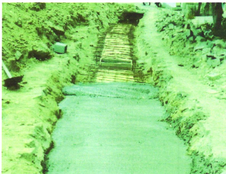
Foto 15 - FABRICAÇÃO, MONTAGEM E DESMONTAGEM DE FORMA PARA RADIER, PISO DE CONCRETO OU LAJE SOBRE SOLO, EM MADEIRA SERRADA, 4 UTILIZAÇÕES. AF 06/2021
