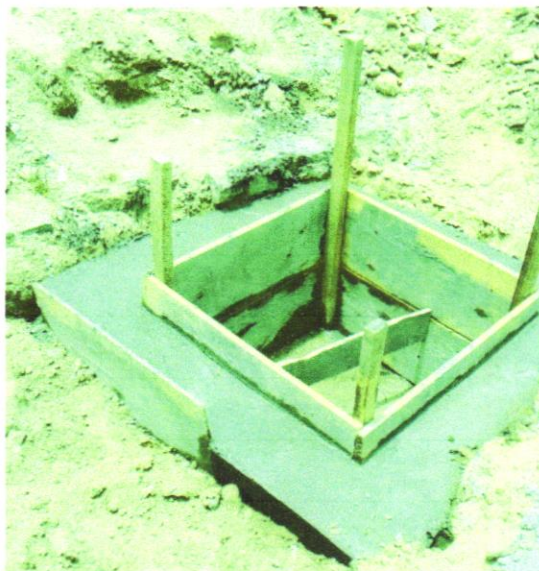
Foto 09 - CONCRETO FCK = 25MPA, TRACO 1:2,3:2,7 (EM MASSA SECA DE CIMENTO/ AREIA MÉDIA/ BRITA
