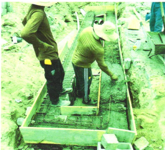
FOTO 4 - FABRICAÇÃO, MONTAGEM E DESMONTAGEM DE FORMA PARA RADIER, PISO DE CONCRETO OU LAJE SOBRE SOLO, EM MADEIRA SERRADA, 4 UTILIZAÇÕES.
